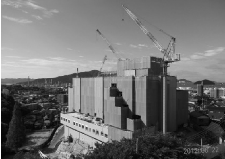
新病棟建設現場
