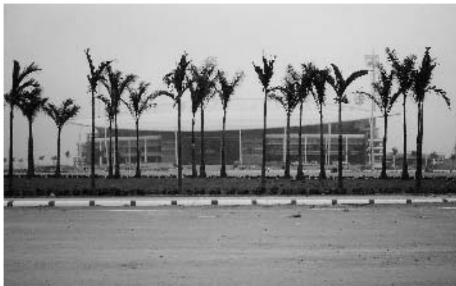
建設中のアジア大会 陸上競技場
