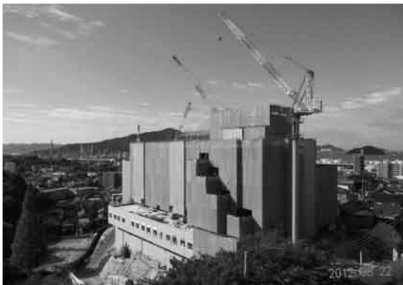
新病棟建設現場
