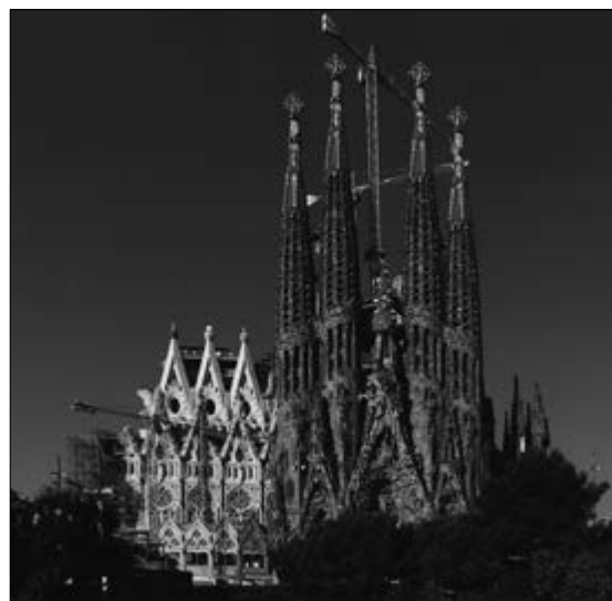
工事中のサグラダ・ファミリア
