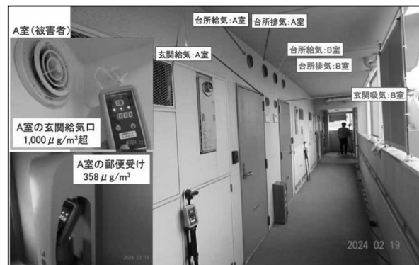
図11 台所換気扇→共用廊下→隣家への被害
